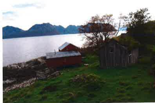
Årberg: Bygningsmiljø Tinastua m.m.
