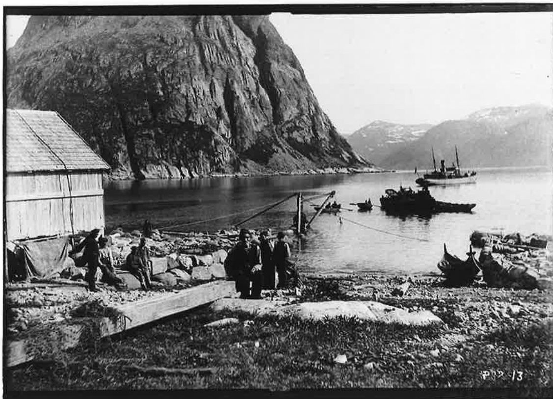
Anlegg av stø i Barbogen – slutten av 1800-tallet
