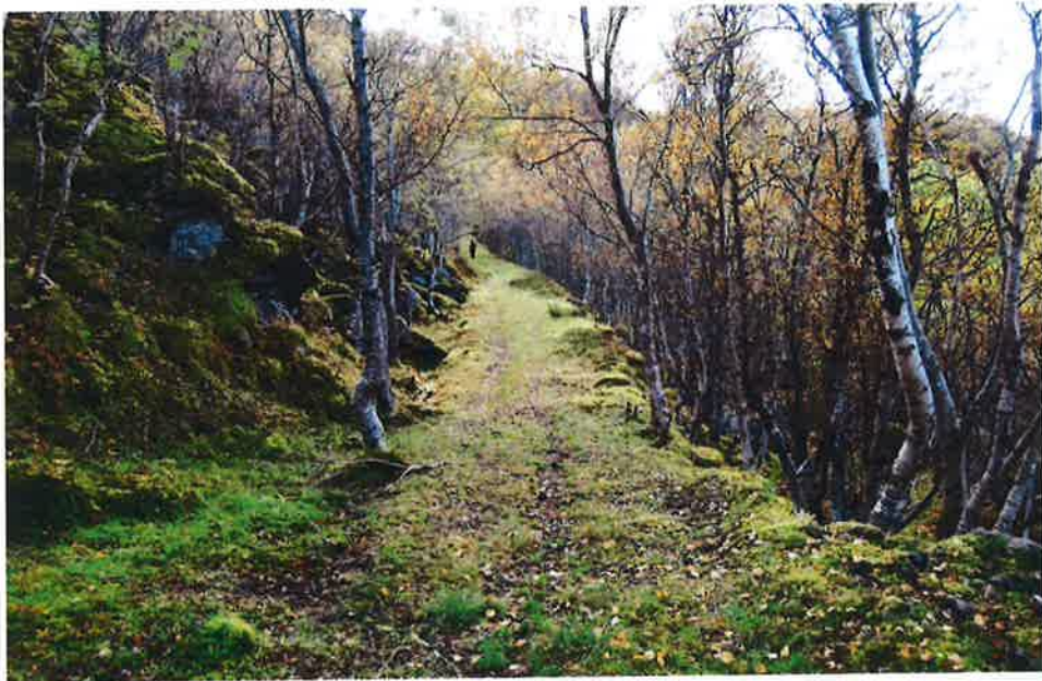
Den flotte veien fra Leikvika opp mot Årbergsnakken. Ca 1,3 km lang og 3-3,5 m bred. Murt opp enkelte strekninger
