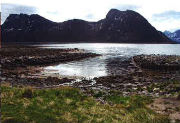
Grunnfarnes ytre: Statsstøa fra 1902
