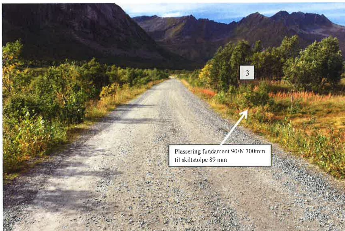
3: Fartsgrense 30 km/t (ensidig) plassert 50 m fra vegkryss til fylkesveg 86 (Ny stolpe til skilt er ikke inntegnet)
